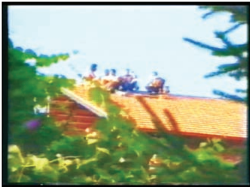
Rue du Broeck 30, 1070 Anderlecht (House Roofing), VHS footage video still (1990), 2025 Rue du Broeck 30, 1070 Anderlecht (Покривање куће), кадар из ВХС видеа (1990), 2025.
